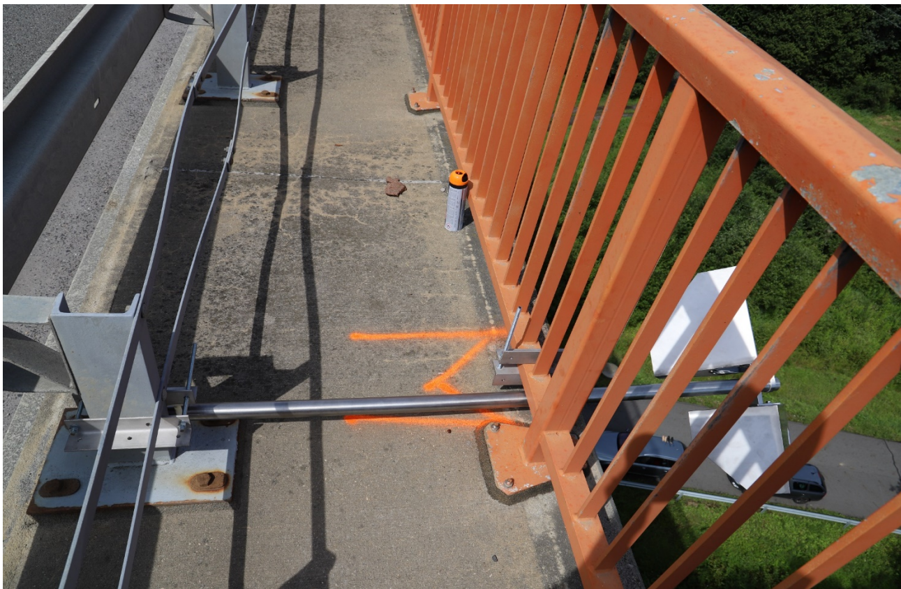
Obr. 6 – Způsob přichycení koutových odražečů k mostu
