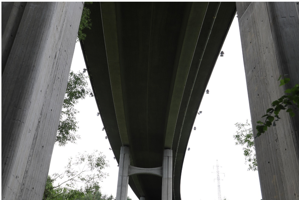
Obr. 8 – Pohled proti směru staničení na 4. pole mostu ze stanoviska radaru R_2
