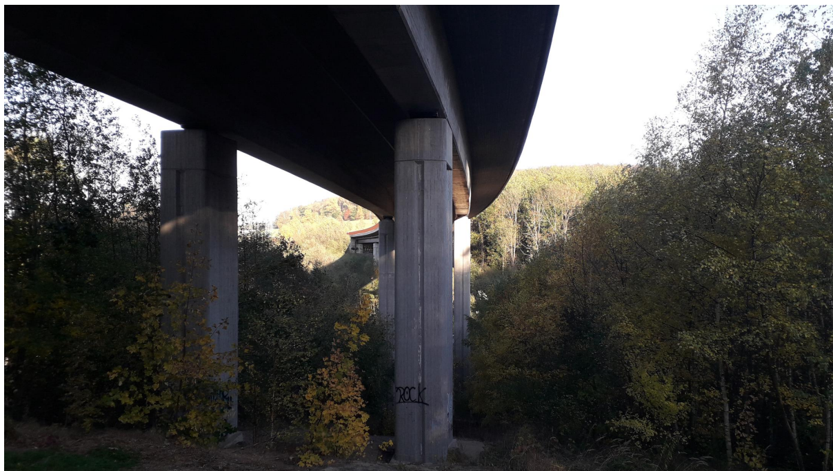
Obr. 1 – Spodní pohled na nosnou konstrukci zkoumaného silničního mostu ev. č. 19-063 u Pelhřimova
