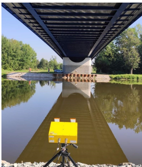
Obr. 3 – Pohled na ocelové příčnický mostu ze stanoviska radaru R 2 (od Valů)
