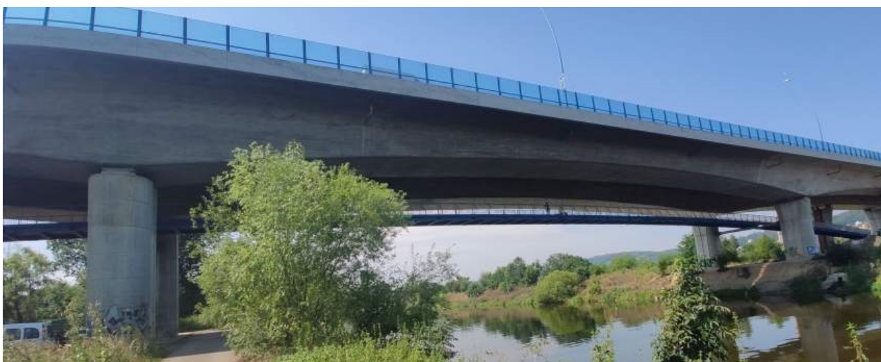
Obr. 1 – Lávka přes Berounku pod Radotínským mostem
