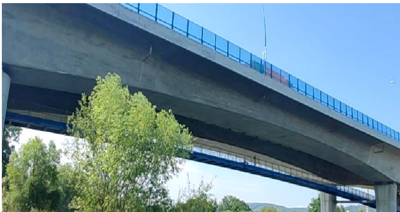
Obr. 7 – Průjezd vozidla nad lávkou
