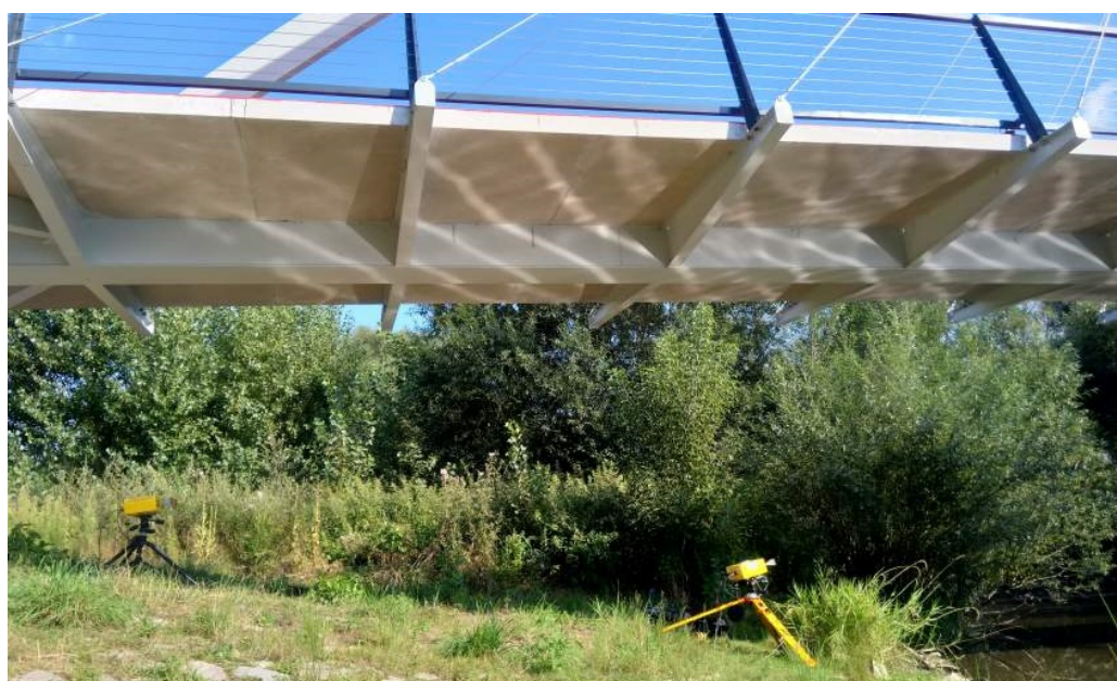
Obr. 3 – Postavení obou radarů pod lávkou
